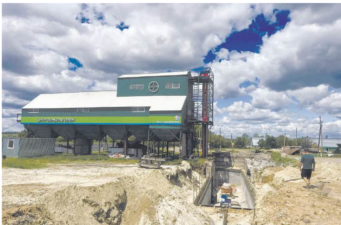
Реконструкция завальной ямы на току в Дибровом
