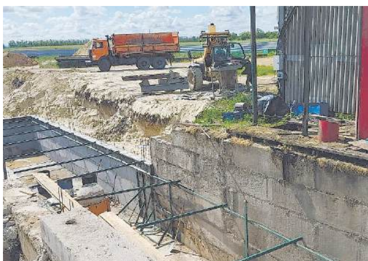
200 бетонных блоков, 600 тонн песка, десятки метров труб и транспортёров
